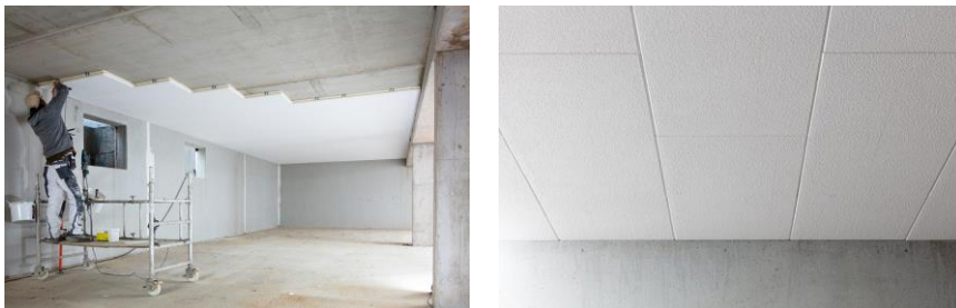
LINITHERM PAL TG BioZell, Verarbeitung; fertige Tiefgaragendecke; Fotos: Linzmeier
